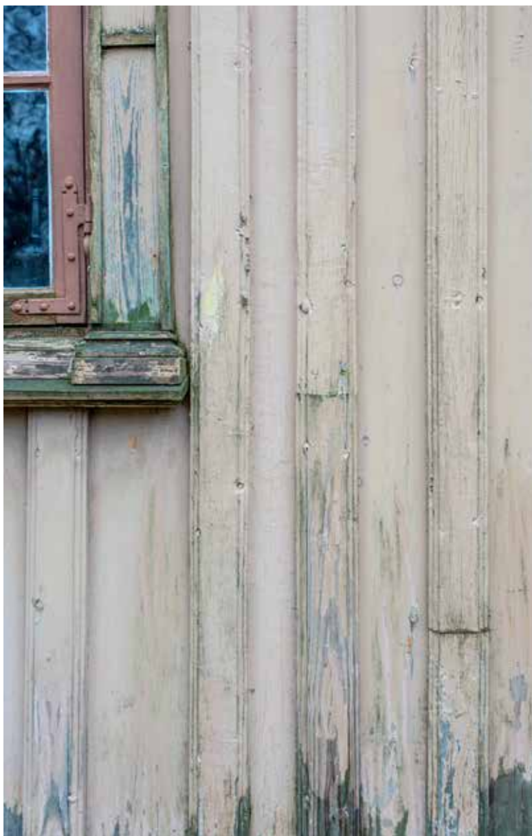
Over: Malingslitasje og avflassing gerikter, panel og nær sokkellist.
