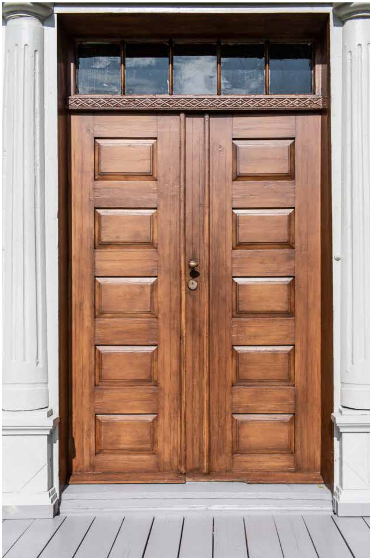
Hoveddør og smyg ferdig ådret. Foto 5 september 2019.
