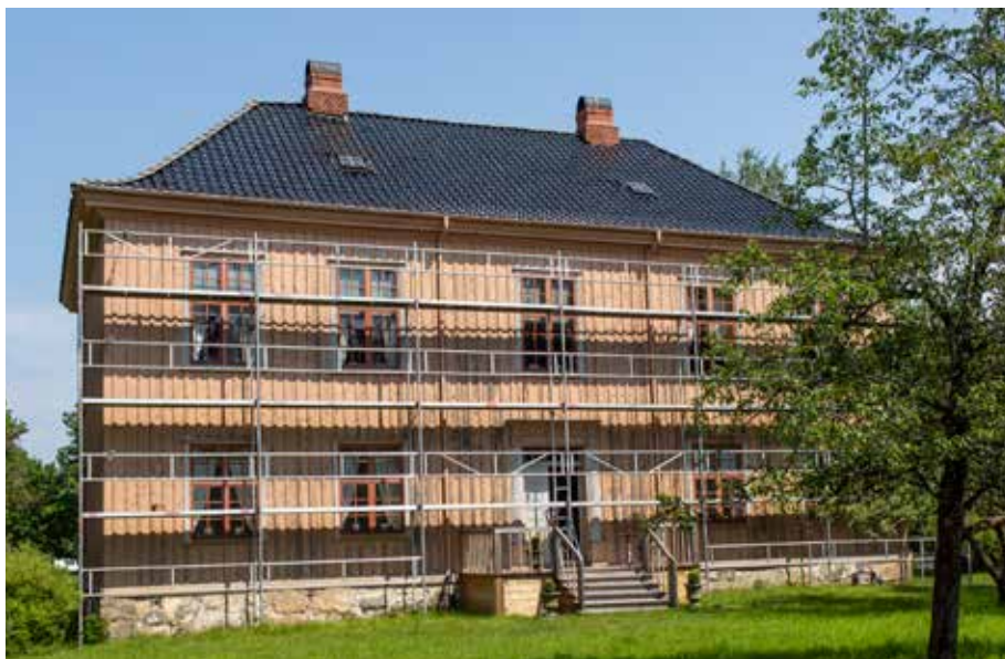
Over: Stillaset er satt opp. Sydfasaden.
