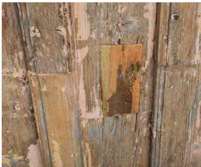
Over: Mindre innbøtinger av nytt tre østfasaden i første/annen etasjes skillet. Skadene er gamle.
