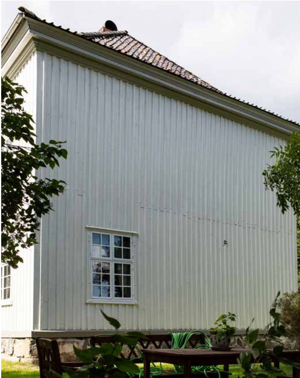
Østfasaden ferdig malt. Foto 5 september 2019.
