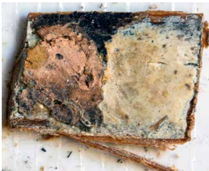
Panel, fragment fra gjenbrukt underligger. Tildekket felt øverst under gesimslist. Søl.
