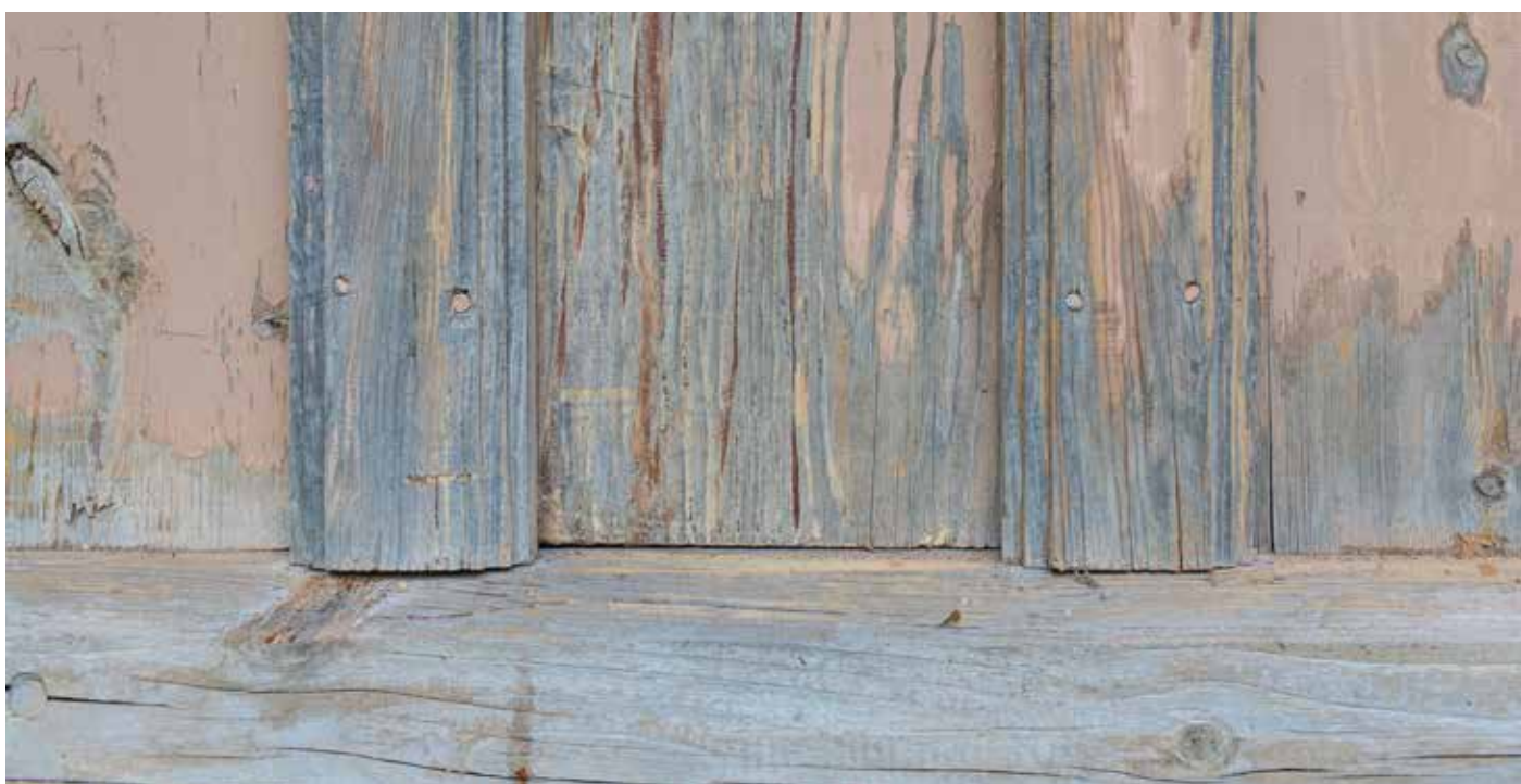
Under: Generelt svært god tilstand i overgangen panel sokkellist åpenbares etter skraping
