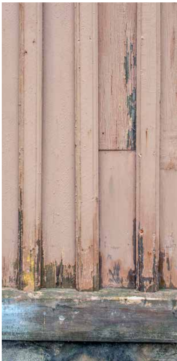
Under: Generelt svært god tilstand i overgangen panel sokkellist åpenbares etter skraping
