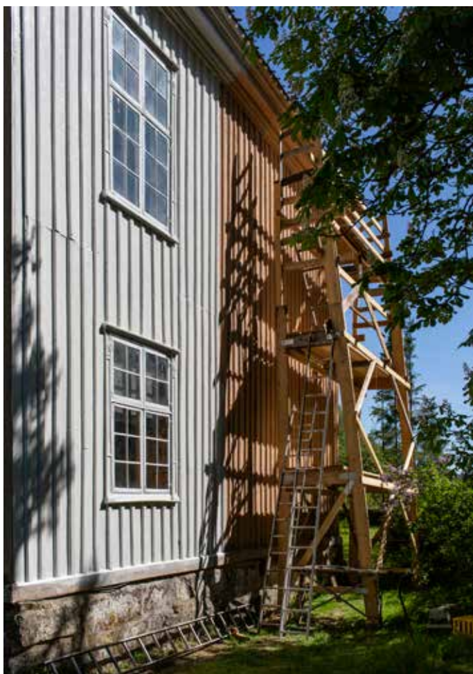
Foto fra arbeider på vestveggen 2021. Det øvre vinduets venstre sidegerikt var gjenstand for undersøkelsen. De tre dråpene oppunder diamantskjæringen øverst på gerikten ble antatt å være mest uberørt av skraping og vær og vind.
