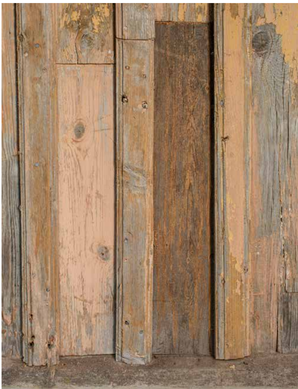
Under venstre: Utskifting av panelbord østfasade mot sokkellist.
