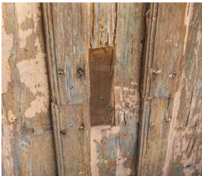
Over: Mindre innbøtinger av nytt tre østfasaden i første/annen etasjes skillet. Skadene er gamle.
